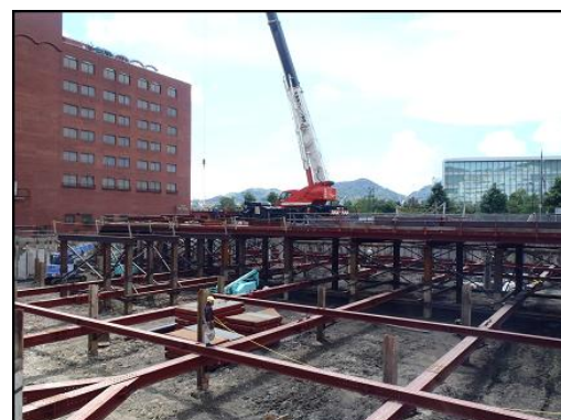
1段目切梁支保工架設状況
