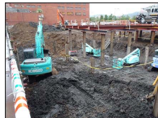
土工事(1次掘削)施工状況
