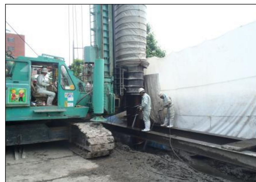
山留壁 (SMW) 工事施工状況
