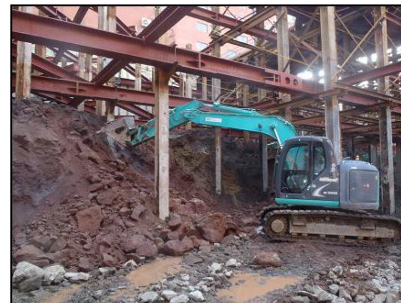
土工事(3次掘削)施工状況
