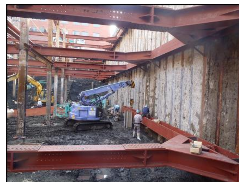
3段目切梁支保工架設状況
